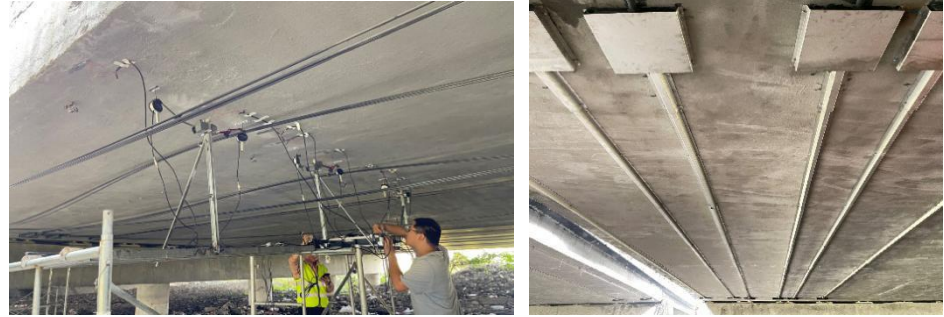
图10 宁波绕城高速慈城大桥预应力碳纤维筋加固
