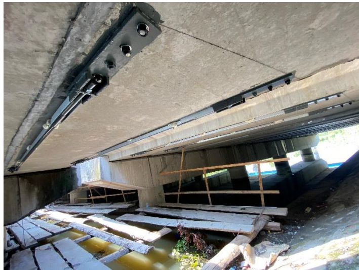
图14 宁波江北区竹桥头桥碳纤维筋加固
