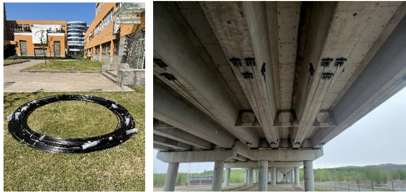
图11 内蒙古洮儿河大桥碳纤维筋加固
