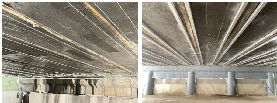
图9 宁波兴宁桥预应力碳纤维筋加固
