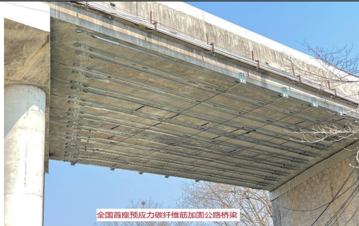
图7 文成县李井中桥预应力碳纤维筋加固
