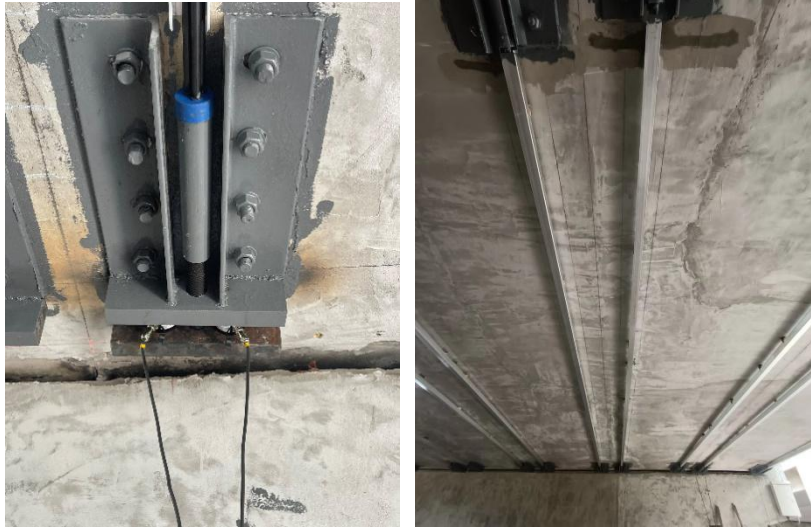
图13 四川资阳车苑南路桥碳纤维筋加固
