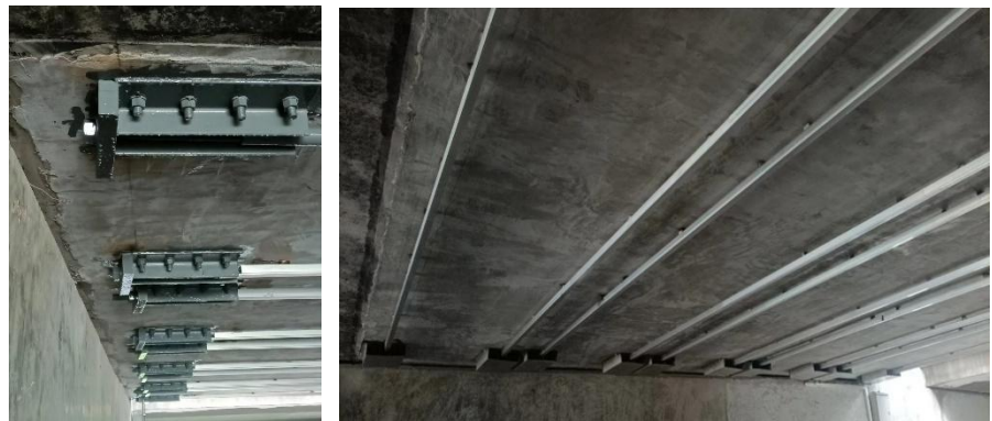
图12 杭州湾大桥南连接线K1425+870.8桥碳纤维筋加固
