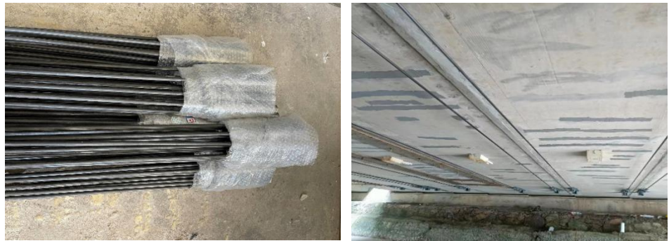
图8 宁波象山县旦门盐场桥预应力碳纤维筋加固
